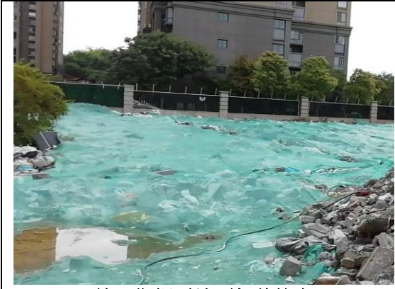
施工期裸露地面加盖篷布
