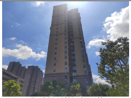
项目东侧 浮村新城居民楼
