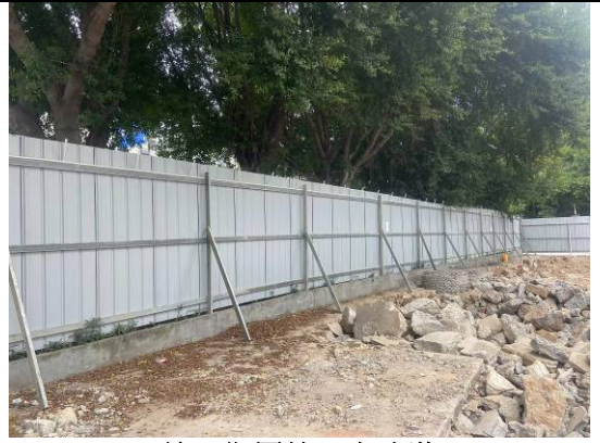
施工期围挡及水喷淋
